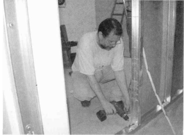
Die ein oder andere Bohrmaschine bzw. Bohrer hatten große Schwierigkeiten mit den Stahlbetondecken und -Wänden.
