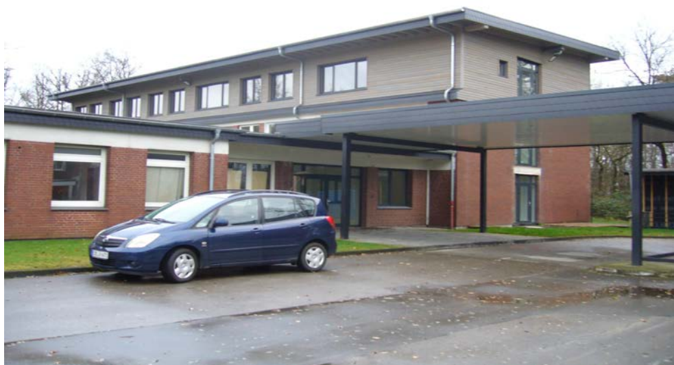
Haupteingang zum ehem. SanRevier Die ehemalige Bettenstation ist um eine Etage gewachsen.
